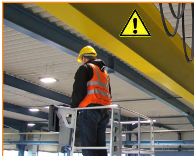
Beim Arbeiten in der Höhe droht die Gefahr der Einklemmung
